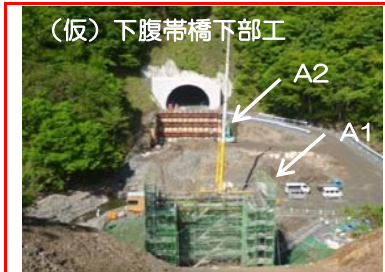
⑦施工：戸田・岩田地崎
