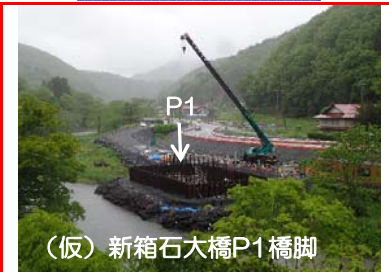
⑰施工：安藤・間
