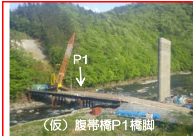
⑩施工：大豊建設
