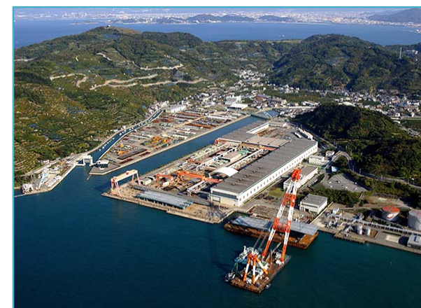
【高田機工(株) 和歌山工場】
