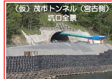
⑤施工：前田建設工業
